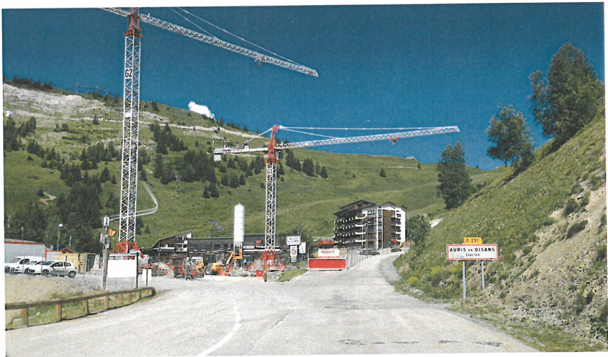
État actuel des travaux sur UZ 1
