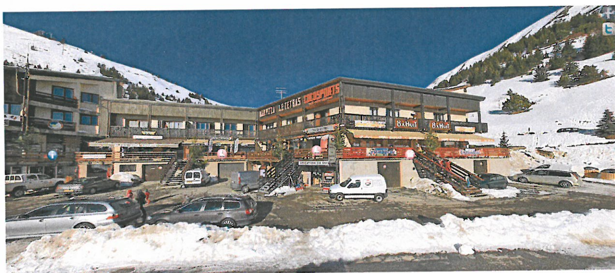
Vue générale du bâtiment sur UZ 3
