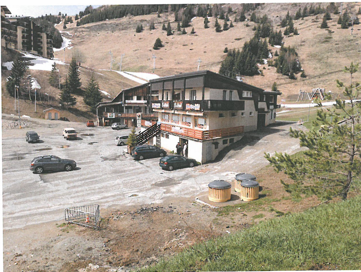
Bâtiment sur UZ 3 état actuel angle Nord-ouest
