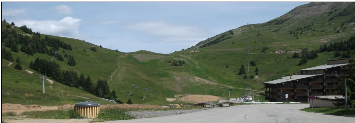
Photographie 32 : Bas de la station en été
